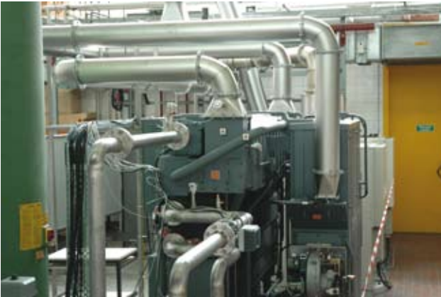
Kraft-Wärme-Kälte-Kopplung: Absorptions-Kältemaschine mit Abgasen von Mikrogasturbinen zur dezentralen, umweltfreundlichen Energieversorgung auf einer Karibikinsel, Institut für Thermische Strömungsmaschinen in Kooperation mit dem European Institute for Energy Research (EiFER)
